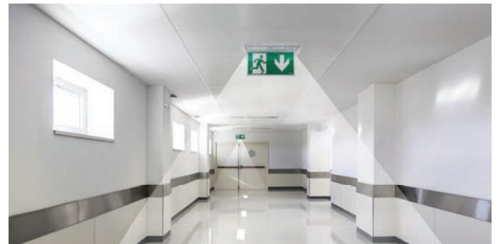
Pose plafond : Éclairage couloir
