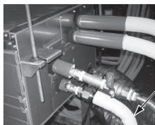
Installez une soupape anti-retour pour empêcher l'eau dans le circuit d'eau de revenir dans le tuyau d'alimentation en eau et de l'inonder, ou pour retirer le flexible d'alimentation en eau une fois l'opération d'évent d'air terminée.
