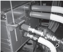
Installez une soupape anti-retour pour empêcher l'eau dans le circuit d'eau de revenir dans le tuyau d'alimentation en eau, ou pour retirer le flexible d'alimentation en eau une fois l'opération d'évent d'air terminée.
