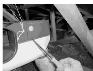
Ouvrir la trappe électrique à l'aide d'un tourne vis plat,
