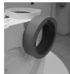
Le piquage est prêt à recevoir le conduit de rejet.
