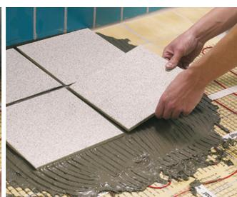
Appliquer la colle à carrelage CS2 et positionner les carreaux de carrelage. Porter une attention particulière à ne pas blesser le câble avec le peigne à carrelage.
