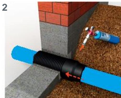
2 Glisser le manchon thermorétractable à moitié sur le tube de protection annelé et à moitié sur la gaine puits climatique. Utiliser des gants de protection pour presser sur la gaine le manchon rétractable ramolli.
