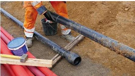
6/ Lubrifier le joint du raccord avec un lubrifiant pour assemblage de canalisations à joints d'étanchéité, ne contenant ni tensioactif ni graisse ni huile – utiliser un lubrifiant alimentaire compatible pour le contact avec l'eau potable.
