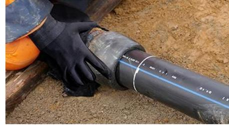
8/ Emboiter le tube dans le raccord par poussée uniforme jusqu'à l'indicateur d'insertion.
