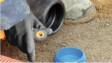
5/ Nettoyer le tube avec un chiffon propre. Vérifier la non présence de rayures dans la zone d'emboitement. Vérifier la propreté de la bague en résine acétal et son emplacement, ainsi que la propreté du joint. Si besoin les nettoyer également.
