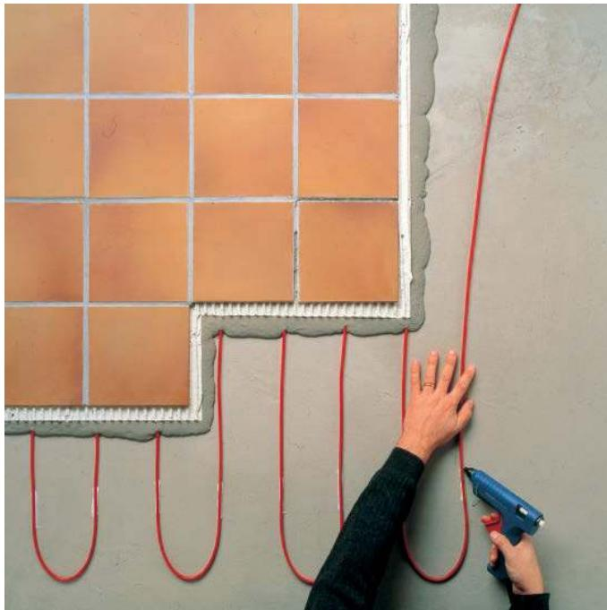
Raychem T2Red est un câble autorégulant de chauffage par le sol dont la pose n'entraîne qu'une faible élévation du niveau du sol. Idéal pour les rénovations, il s'utilise sous tous les types de revêtements.
