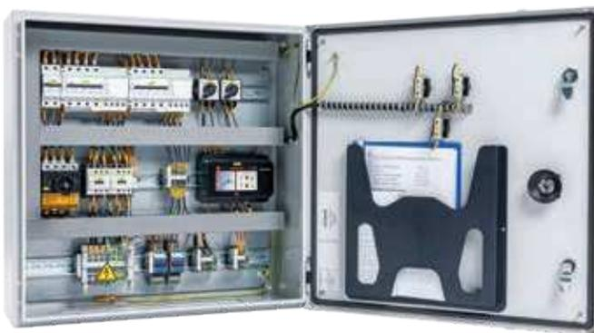
La gamme d'armoires de contrôle nVent RAYCHEM SBS offre une solution complète pour les câbles chauffants autorégulants nVent RAYCHEM pour la protection contre le gel des tuyaux et le maintien de la température. Cette armoire offre un contrôle avec sonde de température sur tuyauterie et / ou une option ambiante PASC (Proportional Ambient Sensing Control).
