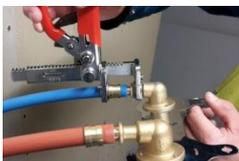
Enfilez les bagues laiton, évasez et connectez-les tubes, sertissez directement les sorties de cloison
