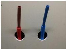
Percez les trous de diamètre 60 mm à la scie cloche puis ajustez la longueur des tubes
