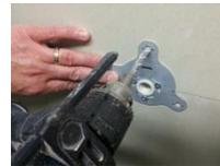
Alignez le niveau de la platine puis percez 5 trous de fixation de diamètre 8mm
