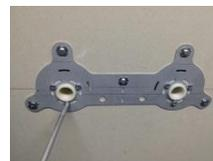
Bloquez les vis des sorties de cloison sur la platine. Retirez les vis des chevilles expansées
