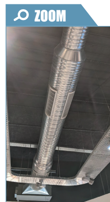
Centrale VCG, conduit galva et GSDG
