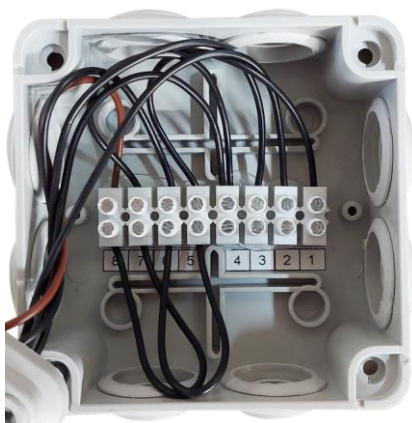
Fig. 8.2 Bornier du boîtier de commande câblé.
