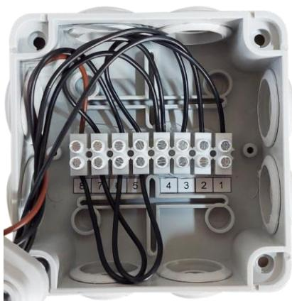
Fig. 8.2 Bornier du boîtier de commande câblé.
