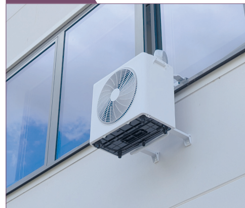
Vue de l'unité extérieure et du système d'accroche fourni
