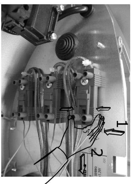
Nel caso di sostituzione della piastra led è sufficiente, sganciare il presa-spina come indicato in figura
