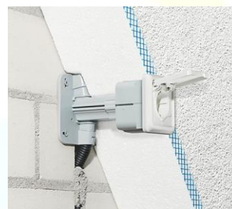
Installation de l'appareillage
