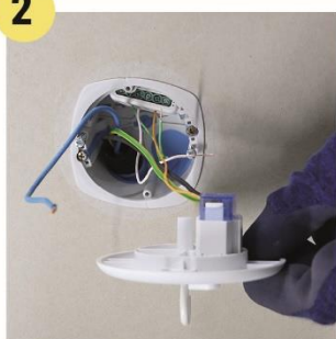
Câblage du socle et du micro module
