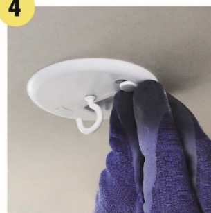
Finition : mise en place des caches de tête de vis
