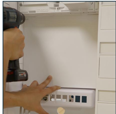
3. Fixer la plaque sur le bac à l'aide de vis autoforeuses.
