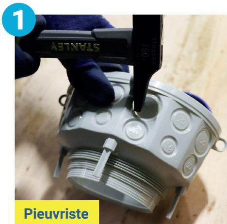
Percer les prédécoupes en fonction du diamètre de vos gaines à passer, avec un marteau.
