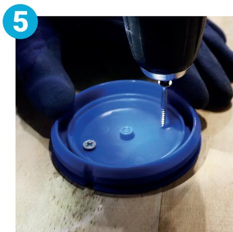
Fixer le couvercle de pose avec des vis, des clous ou des agrafes.
