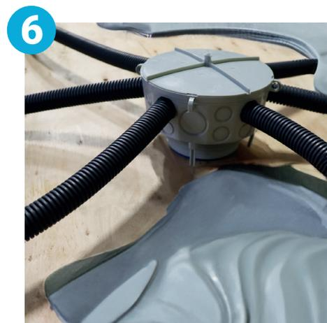
Clipser le point de centre sur le couvercle de pose et couler ensuite la dalle béton.
