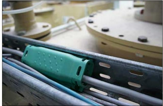
Kit de raccordement à gel intégré, utilisé pour la réparation de câbles „MRO“.
