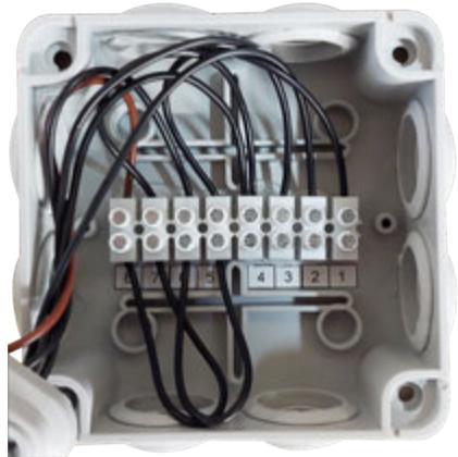
Fig 8.2 Connecteurs du boîtier de commande avec fils.
