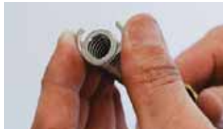
6 Installer la bague fendue derrière le collet battu et la resserrer.
