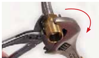
6 Visser au maximum jusqu'au point de blocage avec les outils adaptés (permet l'écrasement de la matière).
