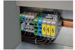
Grâce au câblage latéral, un raccordement des conducteurs ayant une forte section et un rayon de courbure très élevé est également possible.
