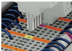
Enfichage correct par dispositif détrompeur
