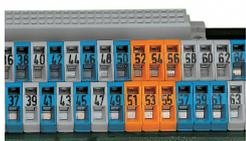
Repérage par impression réalisée directement en usine
