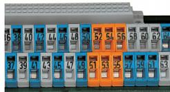
Repérage par impression réalisée directement en usine
