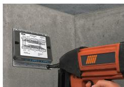
Boîte de distribution WINSTA® montée sur plaque de fixation murale (à fixer par ex. avec une cloueuse).
