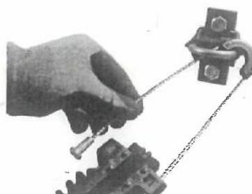
Engager la câblette dans l'anneau de la console d'ancrage
